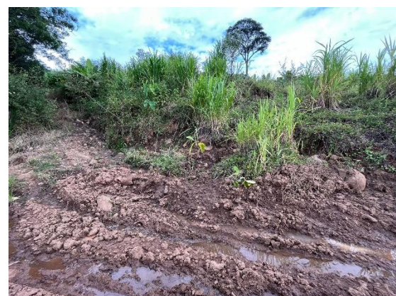
Estragos nas estradas de roça.
