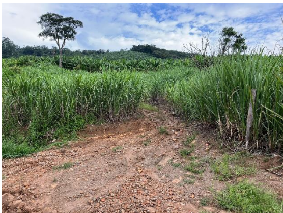
Estragos nas estradas de roça.
