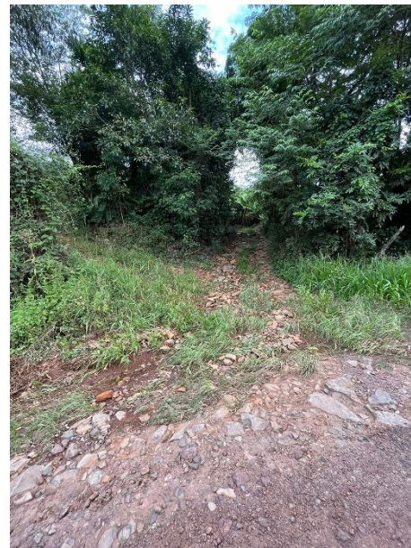
Estragos nas estradas de roça.
